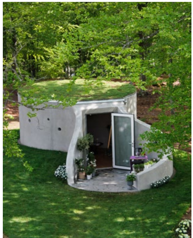
Fasadputsens vitpigmenterad för att ljusa upp betongens naturliga färg.
