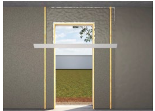
Putsa invändigt med avdragsbanor på samma sätt som på fasaden.
