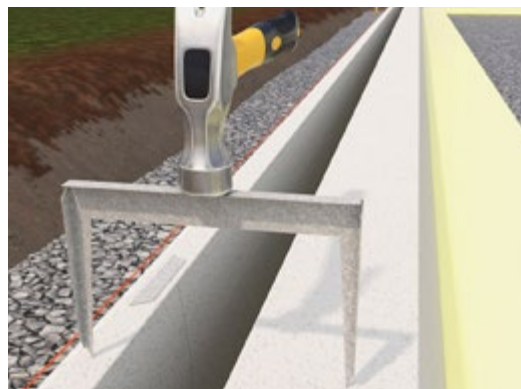
Fäst med breda fixeringskilar mellan de vertikala delarna.
